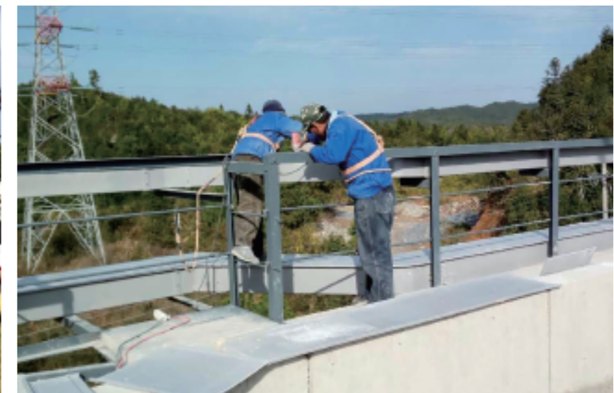
SMC组合式水箱、电缆槽施工现场
